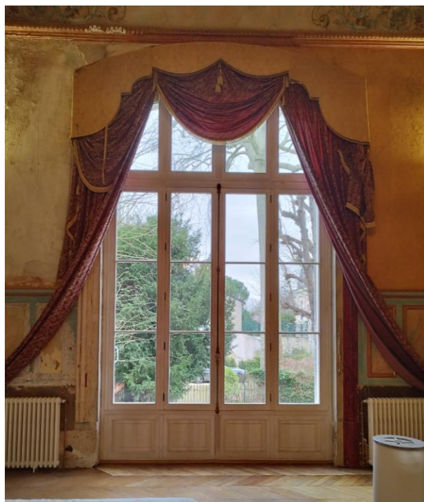
Pose d'une fenêtre monumentale (4 x 5 m). Château de Valmoré. St Germain-en-Laye - 78100 - Déc. 2023
