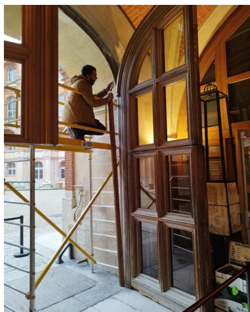
Restauration porte cochère vitrée. Château de St Germain. Saint Germain-en-Laye - 78100 - Nov. 2023
